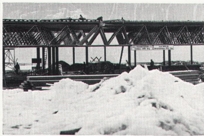
Satellitenstation Leuk: mit Holorib-DLW gebaut.
