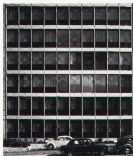
Fassadenelemente. Durch sinnvolle Kombinationen aller Fensterarten mit vorfabrizierten Brüstungen und Stützen entstehen Fassadenelemente modernster Konzeption.
