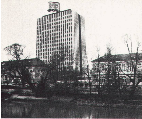
Verwaltungsgebäude der Télévision Suisse Romande, Genève
