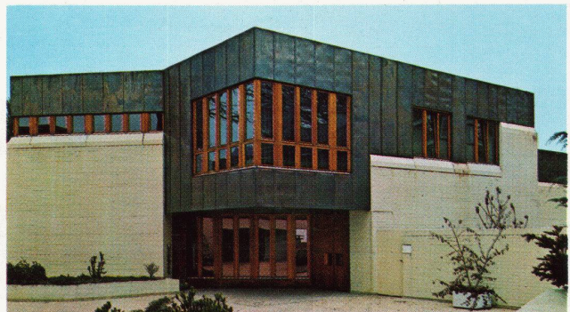
Reformiertes Kirchenzentrum Weinbergli, Luzern – Infrastop Gold 30/23 Arch.-Gemeinschaft Scheuner/Ammann/Baumann/Hodel, Zug und Luzern
