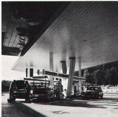
Autobahn-Tankstelle Würenlos LUXALON®-Fassadenverkleidung Typ 150 F (als Decke montiert)
