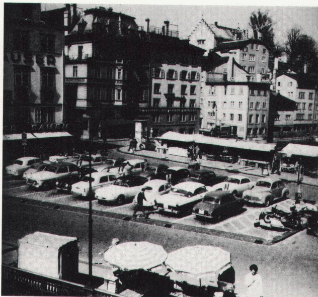
Rathausbrücke vorher (Foto: BAZ)
