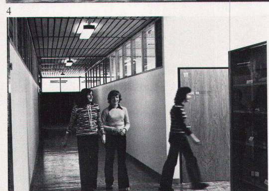
3-6. Ziel des Innenausbau war es, mit Verwendung von Bauteilen aus Holz eine wohnliche Atmosphäre zu schaffen. In den Innenräumen wurde versucht, durch den Einbau von Glasflächen im oberen Bereich der Trennwände und die Aufteilung von Nutzungsbereichen mittels frei stehender Schrankelemente eine Transparenz in der Struktur zu erzielen.
