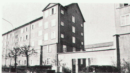
Teilansicht von der Seebahnstrasse aus
