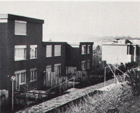
Detailaufnahmen der Überbauung 1
