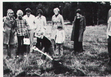
20 Der erste Spatenstich
