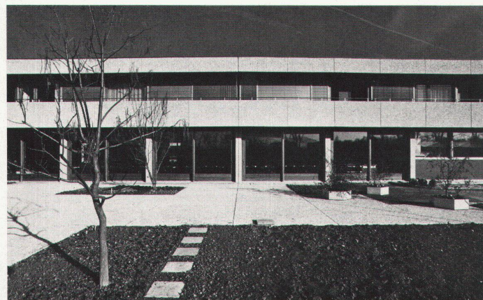
Façade sur réfectoire
