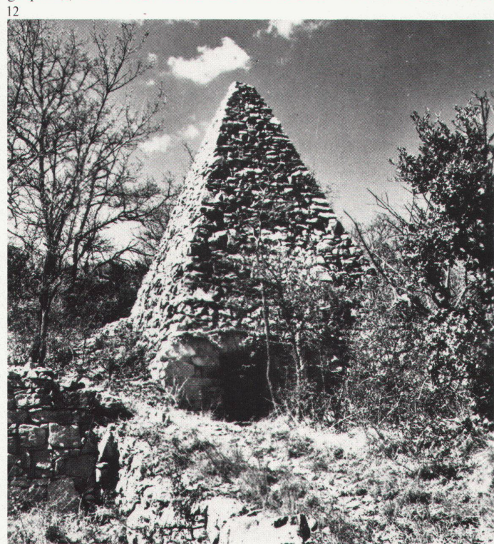
12 Kragsteinbau in der Provence. Innenschale bienenkorbförmig, Aussenschale als Spitzpyramide
