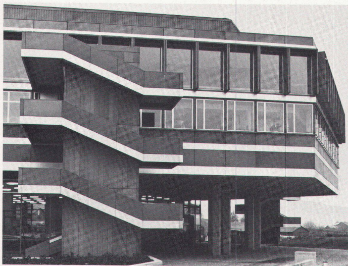
Grosses Hörsaalgebäude, Leichtmetallfassade und Fluchttreppe
