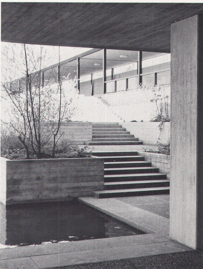
Gartentreppen zwischen Zentralgebäude und Laboratorium für Kernphysik
