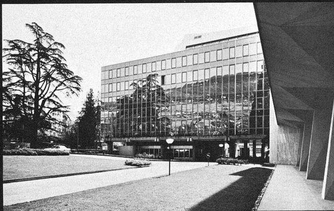
Fassadenpartie zum Eingangshof
