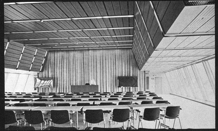
Auditorium im Attikageschoss
