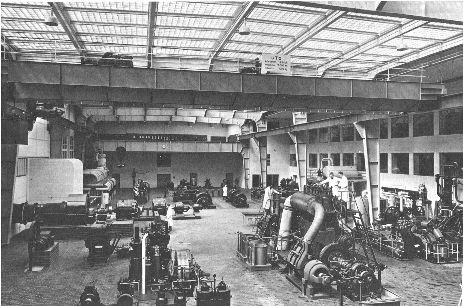
5 Maschinenhalle; rechts die Galerie des Vorlesungstraktes/salle des machines; à droite la galerie de l'aile contenant les salles des cours
