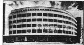
Suvahaus, Bern. Gesamtansicht.
