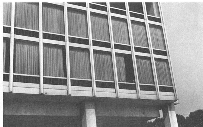
28 Mies van der Rohe, Colonnade Apartments, Newark, N. J., 1969/70; Fasadendetail/détail de la façade. (Foto: P. S., 1963.)
