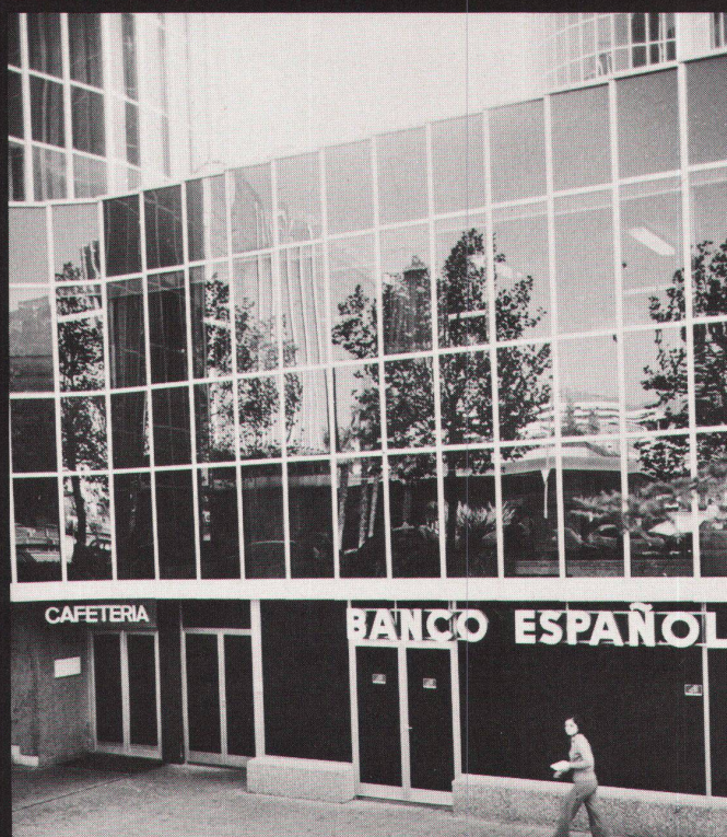
José Antonio Coderch, Manuel Valls Vergés: Bürogebäude «Trade» (1966–69)/Immeuble de bureaux «Trade» (1966–69)
