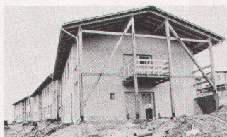
36 Wohnhäuser in Monteaperta / habitations à Monteaperta.
