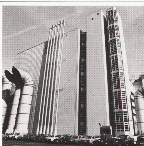
Ein Beispiel für die erfolgreiche Zusammenarbeit zwischen der Ewinag und Elektro-Winkler: Die Installationen im Fernmeldezentrum Zürich-Herdern.
