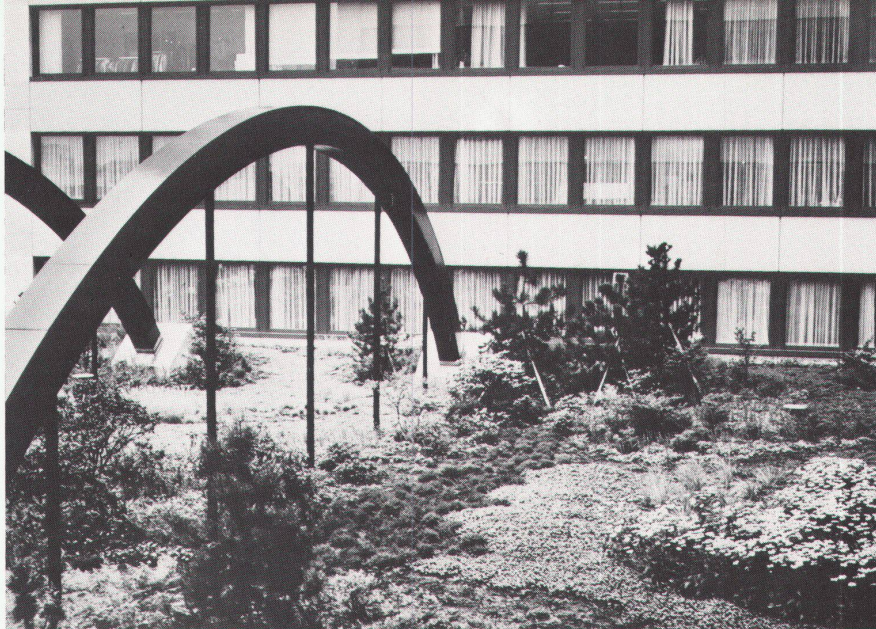
Objekt: Textil- und Modecenter Zürich-Opfikon. Ca. 1700 m 2 Dachbegrünung, Schichthöhe 35 cm. Generalunternehmer: Ortobau AG, Zürich. Architekt: von Tobel, Gurçan, H. Kehrer und Limburg, Zürich. Gartenarchitekt und Gartengestaltung: Fritz AG, Zürich.
