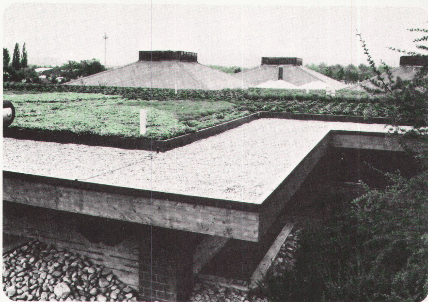
Objekt: Restaurant Seegarten, Park im Grünen, Grün 80, ca. 750m 2 Dachbegrünung, Schichthöhe 17cm. Planung: Architekten Rasser und Vadi, Basel und S.u.M. Zürich. Gartenarchitekten W. Neukom, Zürich und A. Zürcher, Oberwil ZG. Ausführung: Bieber Gartenbau AG , Rheinfelden.
