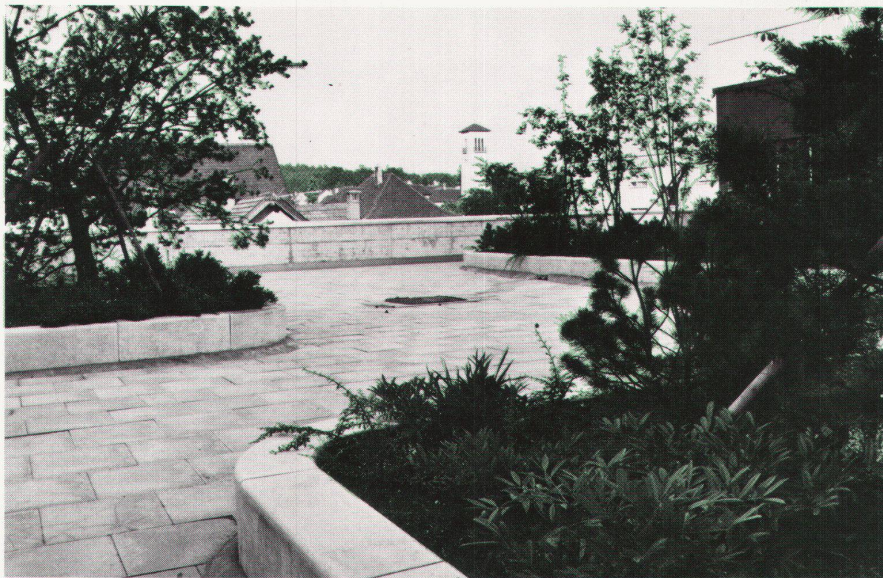
Objekt: Migros Madretsch, Biel 1980, ca. 250 m 2 Dachbegrünung, Schichthöhe 35cm Architekt: Dubler und Müller, Bern. Ausführung: Hans Bracher AG , Bern.
