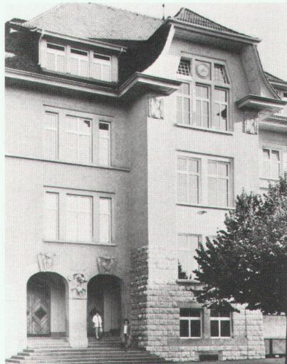
Die neuen Austauschfenster sind auf die bestehenden Blendrahmen der alten Holzfenster montiert. Dank ihrer minimalen Rahmenansichtsbreiten ist die Alisol-Bloc-Konstruktion hierfür ausgezeichnet geeignet und das speziell für solche Austauschfenster entwickelte Blendrahmenprofil ist an die unterschiedlichsten baulichen Gegebenheiten anpassbar. Die Profile sind weiss einbrennlackiert.
