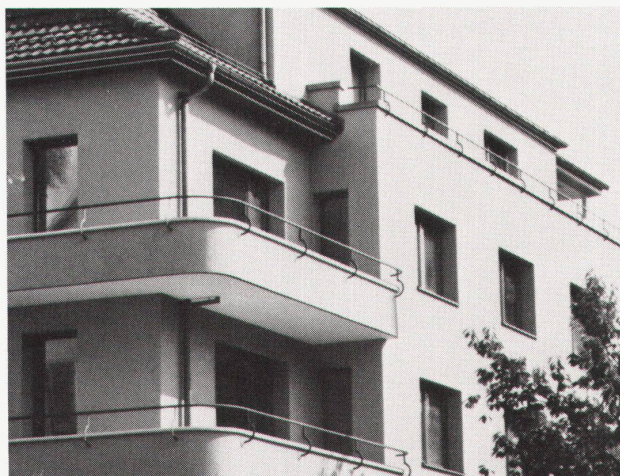
- Mehrfamilienhaus-Sanierung, Dübendorf. 1980. Aussenisolation.
