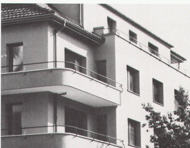
- Mehrfamilienhaus-Sanierung, Dübendorf. 1980. Aussenisolation.
