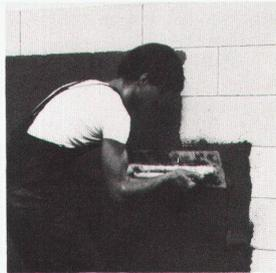
3 Verputzt mit dem SIPOREX-Grund- und Deckputz LAMIT = schlagregendicht und atmungsaktiv.
