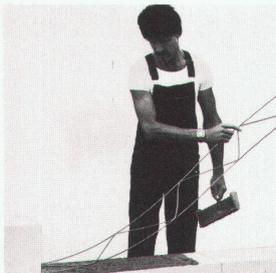
2 Armiert mit der SIPOREX-Stahlarmierung MURFOR = hohe Gebrauchssicherheit.
