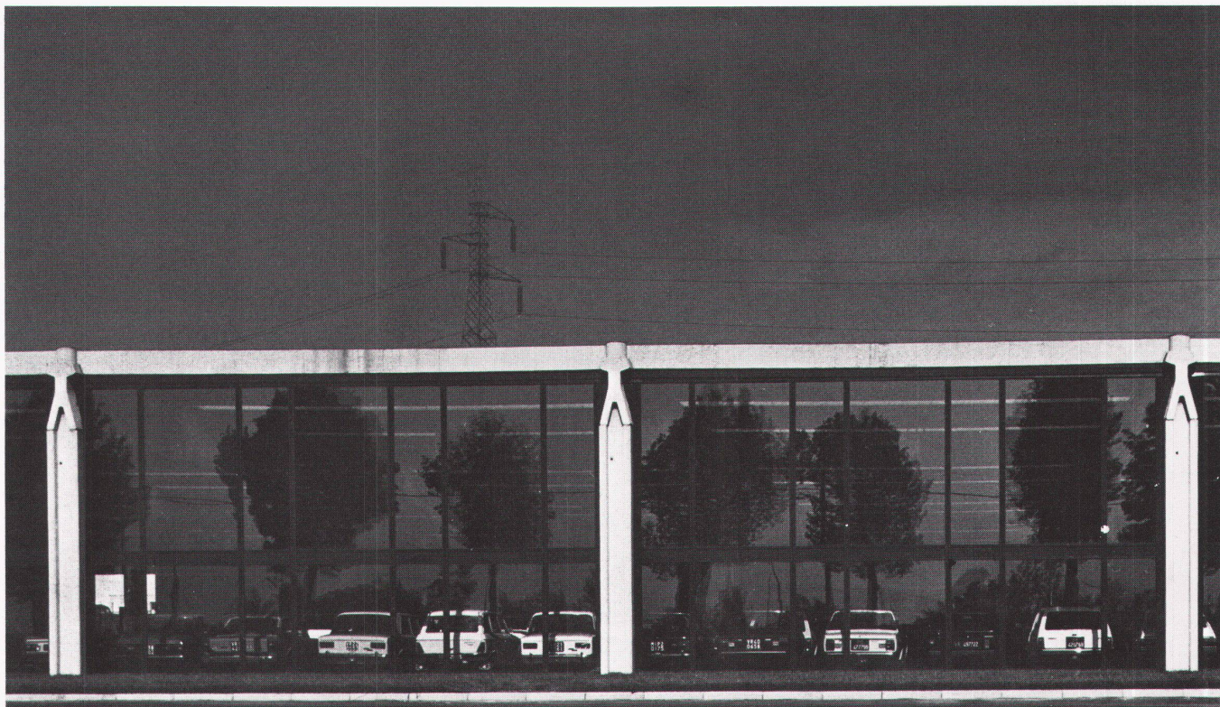
1 Industriegebäude in Bussolengo/ Italien, 1979
