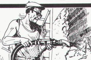
einen Schlag löst! Der Dämmputz wird auf die Welnet-Gitter aufgetragen, welche vorher direkt auf den Altputz befestigt wurden – und fertig!
