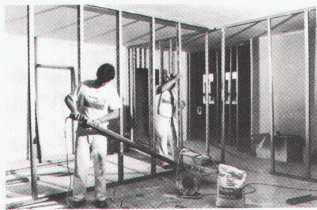
Montage der Metallständer-Unterkonstruktion.
