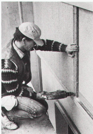
Paneelmontage zwischen Fensterbank und Stockwerktrennprofil
