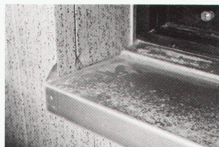
An diesen Fensterbänken und Leibungen dringt kein Wasser mehr in den Baukörper.
