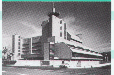
Theo Hotz Fernmeldebetriebszentrum Zürich
