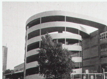
Rampe Parkhaus Migros Herdern
