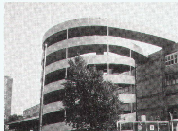
Rampe Parkhaus Migros Herdern
