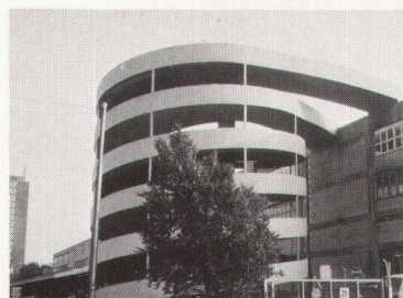
Rampe Parkhaus Migros Herdern
