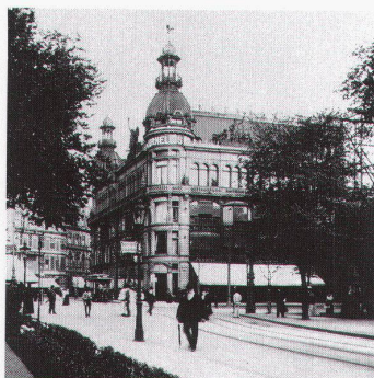
Haupteingang Königsallee Entrée principale Königsallee
