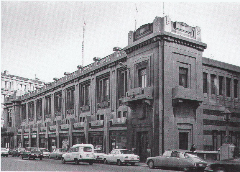
Victor Horta, Palais des Beaux-Arts (1920–1928) Beschränkungen aufgrund eines komplexen Programms, eines knappen Budgets und eines unregelmäßig geformten Grundstücks mit einer die Bauhöhe begrenzenden Auflage. Hortas Gebäude verbindet auf bemerkenswerte Art und Weise städtebauliche Integration mit inneren räumlichen und funktionalen Qualitäten, zum Beispiel beim Eingang mit der Eckrotunde oder mit der durchgehenden Ladenfassade
