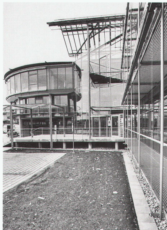
Flughafenverwaltung, Eingang und Halle
