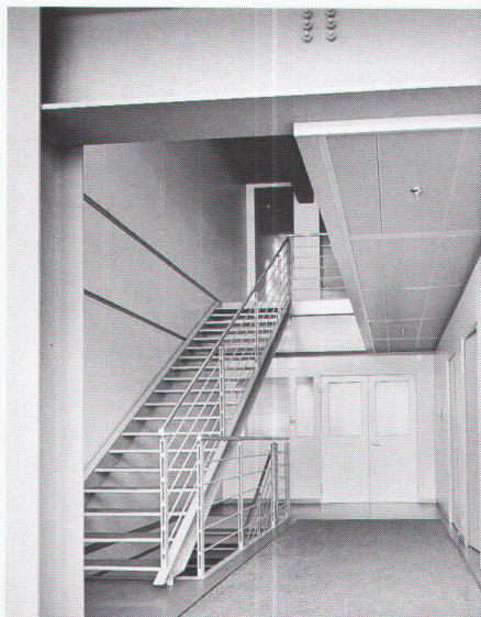
Treppenhaus Cage d'escalier Staircase
