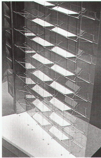
Vorhangwandkonstruktion (Arch/Truss Wall), 1989–1993, Los Angeles Center Construction de paroi-rideau Curtain wall construction
