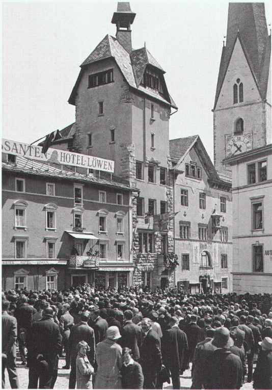
Rathaus vor dem Umbau mit Kirche St. Johann im Hintergrund, um 1928 Hôtel de ville avant transformation avec l'église St. Johann à l'arrière-plan, vers 1928 Town hall before the conversion with the church of St. Johann in the background, around 1928
