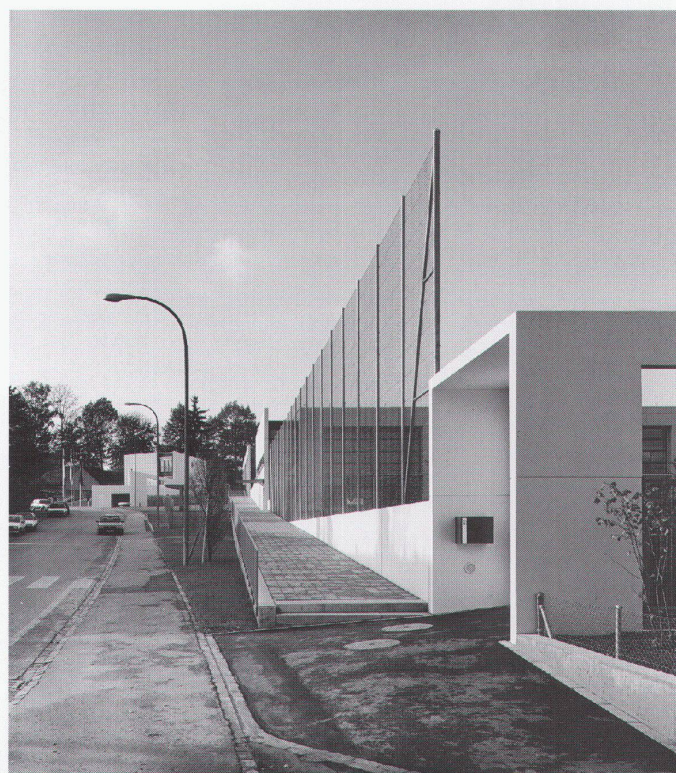
Verbindungsweg längs der Schulanlage
