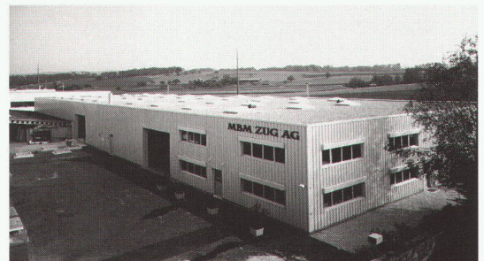
Bei heute europaweit bereits 1 Mio. m 2 Sarnafil T auf Flachdächern verlegt
