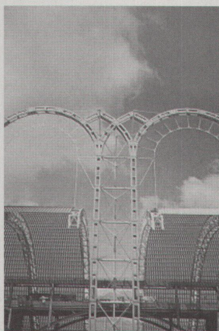
Martorell, Bohigas, Mackay: Pavillon der Zukunft (Pabellón del Futuro), Sevilla, 1992 In jedem Primärbogen ist ein Ring mit kurzen Stahlstangen abgehängt. Die sternförmige Anordnung der Stangen zwischen dem Stahlzugring und dem Steinbogen garantieren eine beinahe perfekte Belastung.
