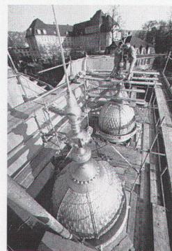
der Forrer saniert. Unter einem alten Farbanstrich fand dann der Restaurator Albert Häusler die Original-Gewölbemalereien aus der Entstehungszeit der Turmhelme von 1889. Die genaue Ermittlung der Farbtöne ermöglichte eine beeindruckende Wiedergabe der reich bemalten Kuppeln.
