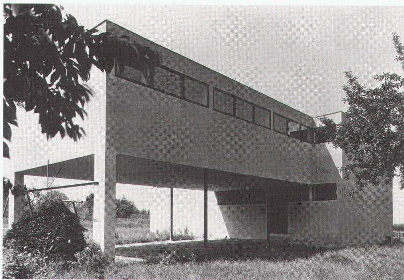
Haus Schaefer in Basel, 1928, von Hans Schmidt und Paul Artaria, vor und nach der Renovation (von Herzog & de Meuron, Basel), die insbesondere die Verglasung des ehemals offenen Erdgeschosses umfasste.
