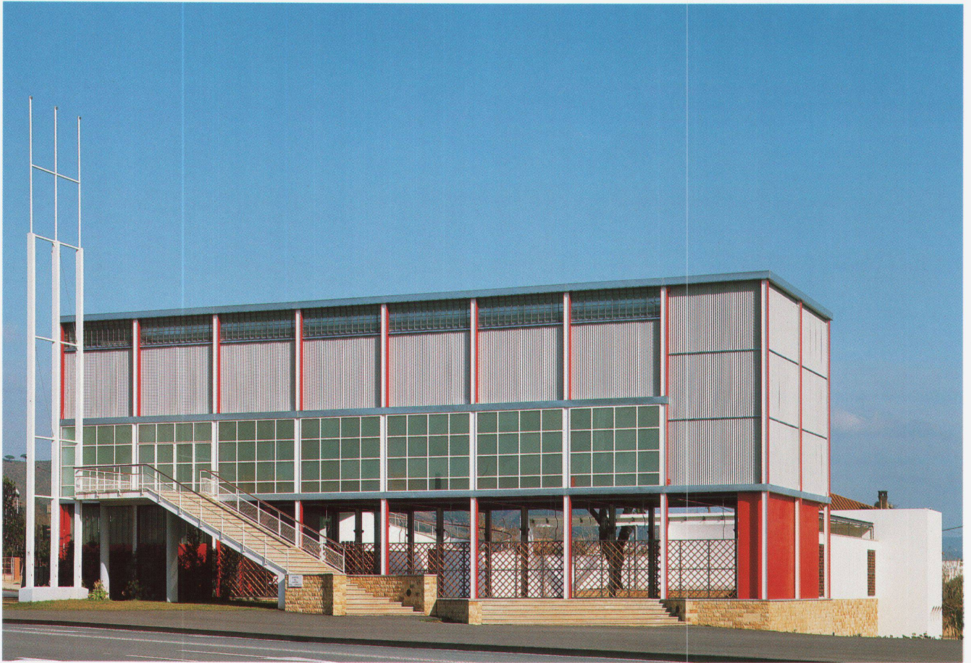
Ansicht Strassenseite, 1992 Vue du côté rue, 1992 View of the street frontage, 1992
