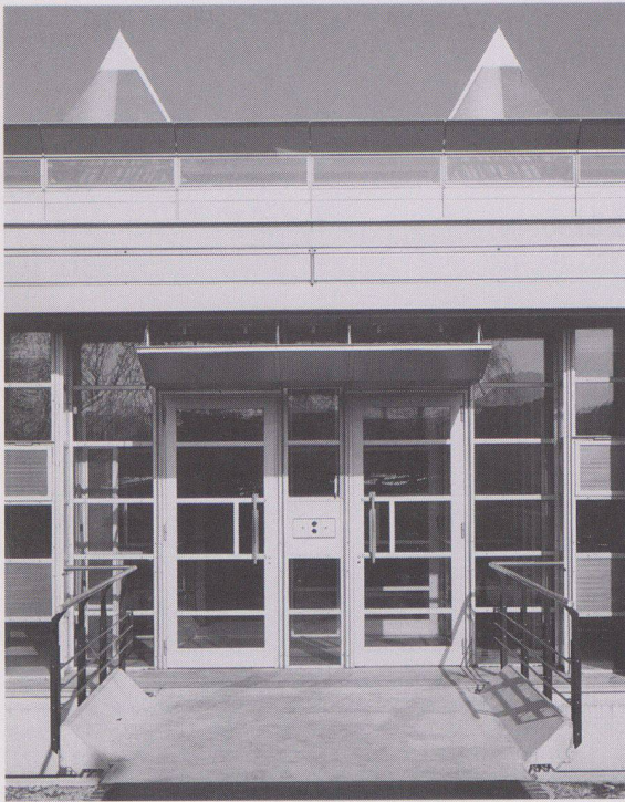
4 1 Wartungshalle für S-Bahn-Züge
