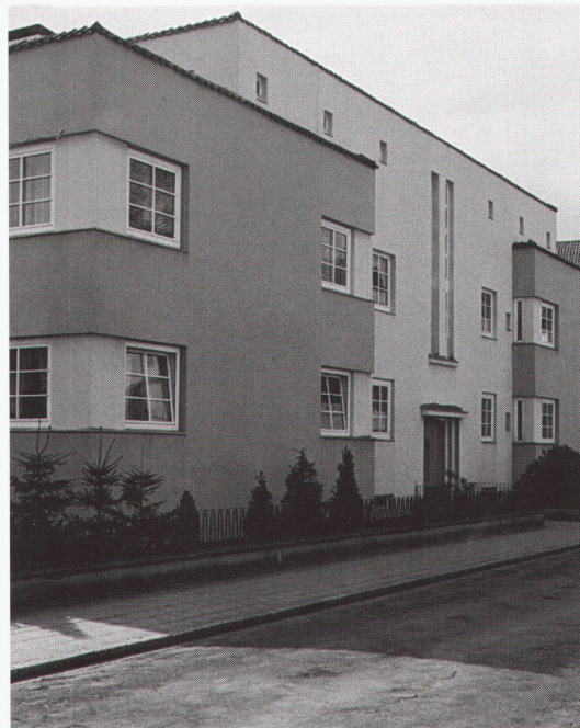
Siedlung «Italienischer Garten», Celle, 1924/25. Architekt Otto Haesler. Heutiger Bauzustand
