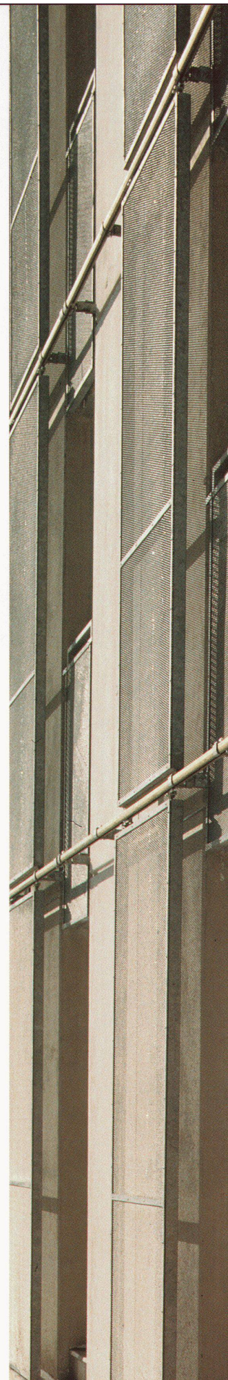
Ostfassade: vorgehängte Schiebe- elemente aus Streckmetall ■ Façade est: éléments coulissants suspendus en métal déployé ■ East façade: sliding curtain wall elements made of expanded metal mesh
