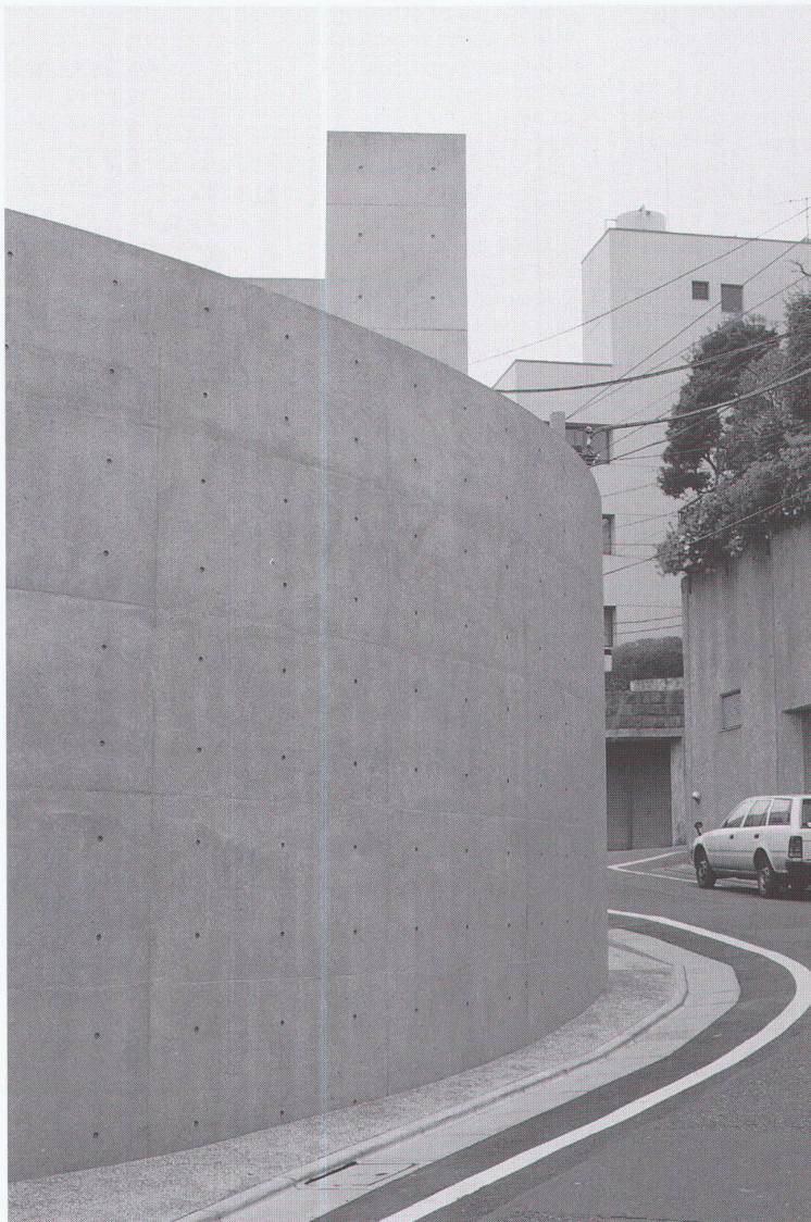
Wohnhaus in Aobadai/Tokio; Architekt: Tadao Ando. Isolation von der Aussenwelt
